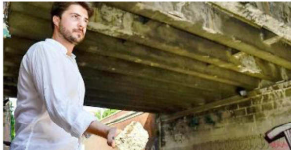
ALLARME Nell'immagine d'archivio un ponte danneggiato
